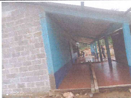
Foto 1: Fundición y pintado del corredor de la dirección
