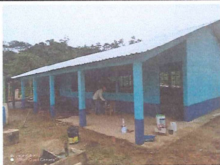
Foto 3: Pintado del piso del corredor del aula.
