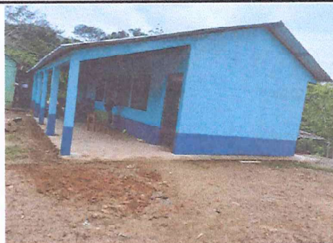
Foto 4: Instalación de los vidrios de los ventanales
