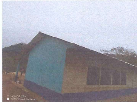
Foto 2: Pintado de paredes en el exterior
