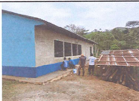
Foto 5: Pintado del exterior parte trasera del aula y dirección
